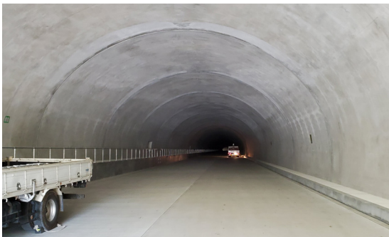
工事に入った自動車道のトンネル
