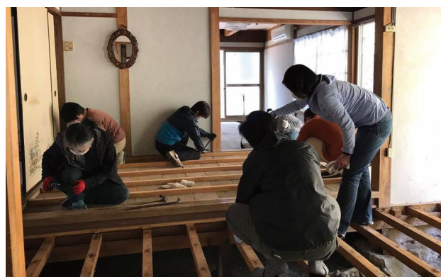
浮いてきてしまった古い床板を剥がして修繕する作業をもイベント化した
